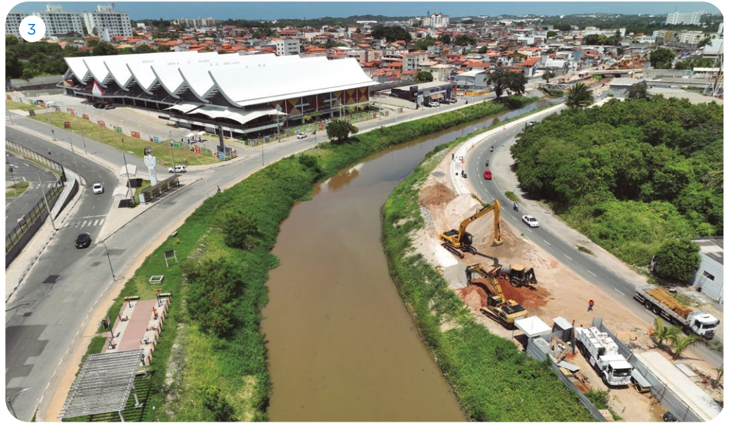
1. Estrutura do barramento no RA-06 (Vida Nova/Quingoma, Lauro de Freitas); 2. Execução do Canal Cajá da Urbis em Lauro de Freitas; 3. Trecho do desassoreamento do Rio Ipitanga (Estrada do Coco - Lauro de Freitas)
