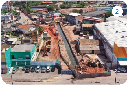
1. Estrutura do barramento no RA-06 (Vida Nova/Quingoma, Lauro de Freitas); 2. Execução do Canal Cajá da Urbis em Lauro de Freitas; 3. Trecho do desassoreamento do Rio Ipitanga (Estrada do Coco - Lauro de Freitas)
