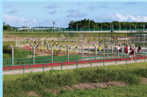
Reservatório de amortecimento inaugurado no Parque Rosa dos Ventos
